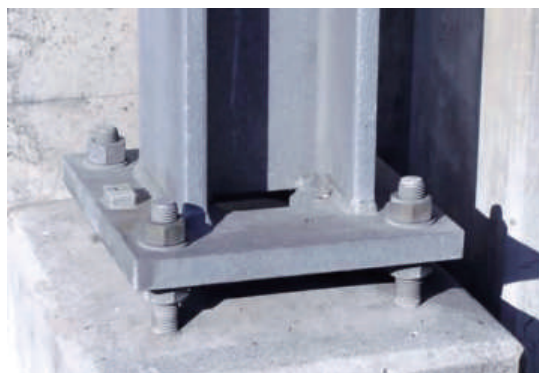
Lidhja e mbërthyer e shtyllës së çelikut me anker- pllakë
