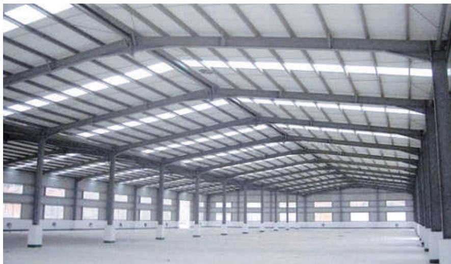
Fig.9.7. Tratë bartëse të mureve të plota –sistem kornize
