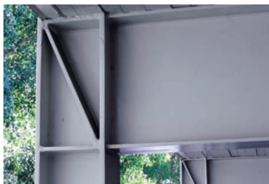
Fig. 9.16 Brinjë për përforcimin e kornizës
