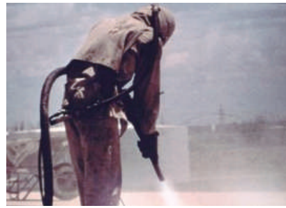
Fig. 4.39 Rërësimi i konstruksiioneve të çelikut
