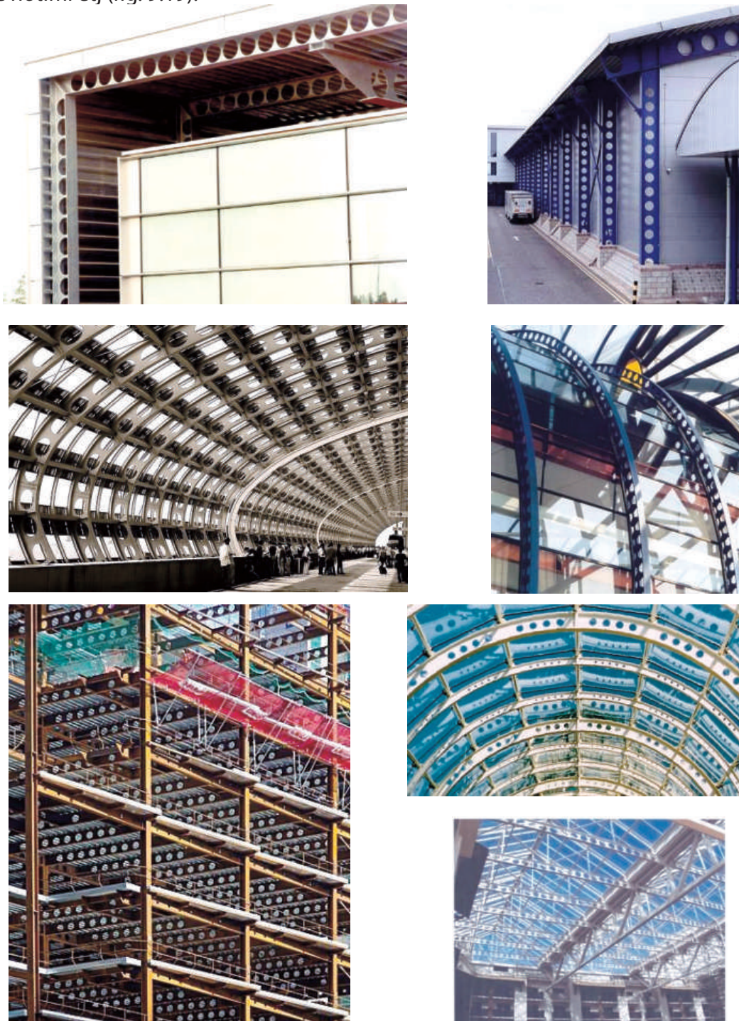
Fig. 9.19 Konstruksionet e ndërtuara prej trave të lastrave të lehtësuar
