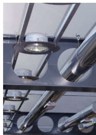
Fig. 9.18 Përçarja e instalimeve nëpër hapjet të trave bartës së lastrave të lehtësuar
