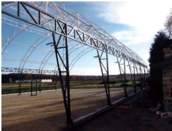
Fig.7.10 Konstruksiione grilash – sistem kornize
