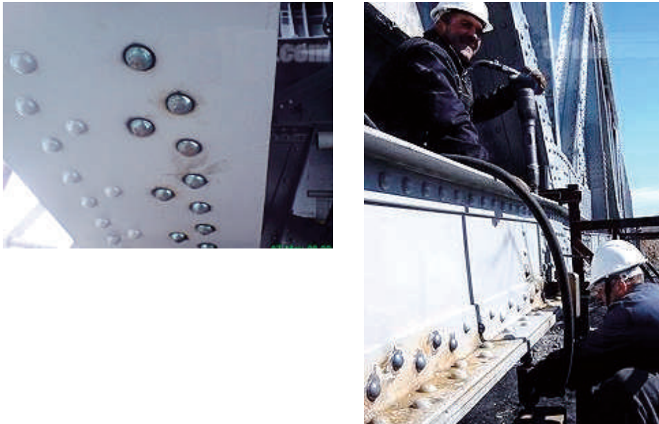
Fig. 5.1 Zëvendësimi i gozhdove të konstruksionet e bëra me gozhdime
