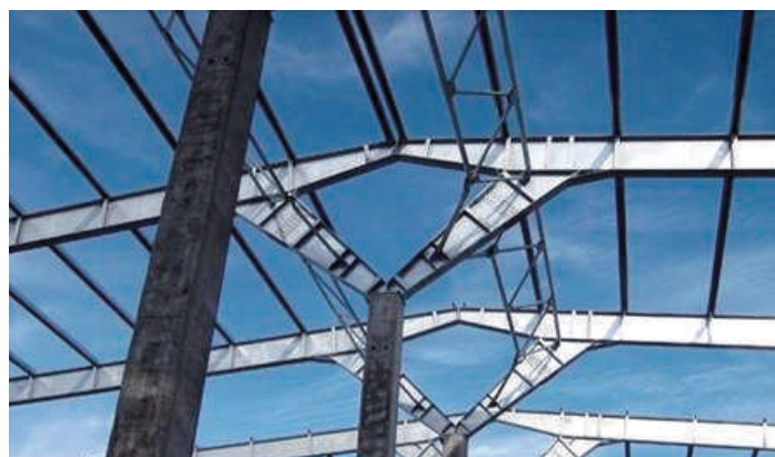
Fig. 9.14 Përforcim i Lastër vertikal te bartësit e salduar të lastrës
