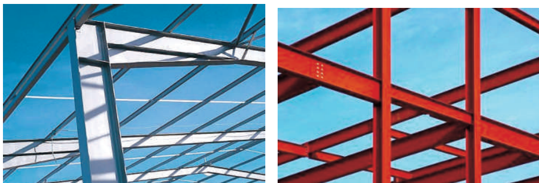
Fig. 9.8 Zbatimi i bartësve mure plota për ndërtesa shumëkatëshe
