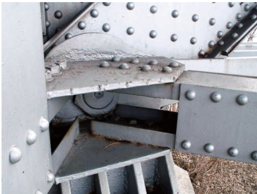
Fig. 5.5 Lidhja e farkuar e konstruksioneve të çelikut
