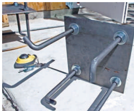
Anker- pllaka me shtyllën anker dhe themeli para montimit.
